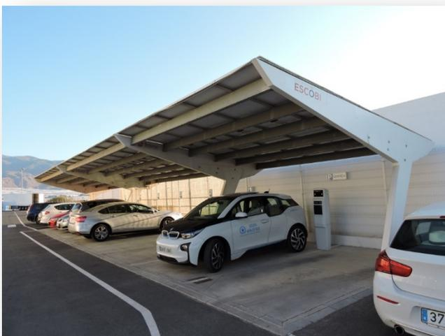
El punto de recarga para vehículos eléctricos (V.E.), permite a la empresa su introducción de forma progresiva en la flota de vehículos, aumentando el ahorro en coste de combustible y utilizando la producción de energía propia generada directamente por el sol.
