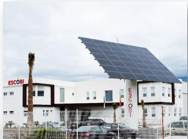
La Suntower es un diseño exclusivo de Proconsult, esta prevista de módulos fotovoltaicos de alta eficiencia. Con una altura de 11,5 metros y es capaz de producir más de 37.000 kWh de electricidad al año. Su diseño permite el paso de camiones, ya que la altura mínima entre la vela y la base supera los 4,30 metros. Incorpora un anemómetro para la medición del viento que inclina la vela en modo horizontal con ráfagas superiores a los 80 km/h.
